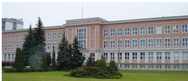
Budynek Wydziału Budownictwa i Inżynierii Środowiska – obecnie
