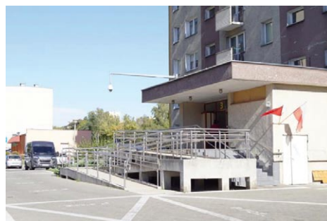
Rys. 2. Widok dobudowanej pochylni przed wejściem do budynku
