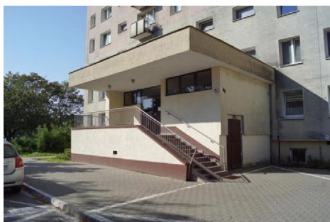
Rys. 1. Bariera architektoniczna w strefie wejścia do budynku w postaci stopni schodów zewnętrznych
