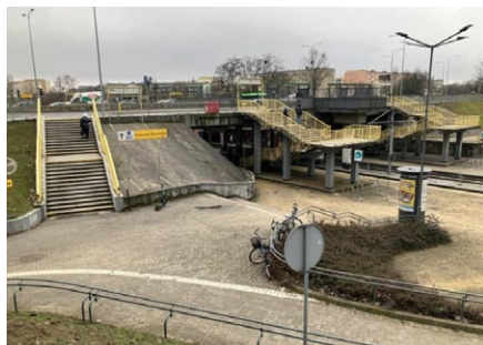
Rys. 3. Widok na węzeł z ul. Księcia Mieszka I. Drogi dojścia z tunelu w kierunku peronów T2 i B1. Widoczne połączenia pomiędzy różnymi poziomami węzła oraz zwężenia drogi wolnej od przeszkód przy schodach łączących przystanki
