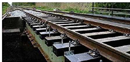
Rys. 2. Podkłady z tworzyw sztucznych [11]
